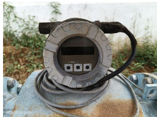
ภาพที่ 2-2 เครื่องวัดอัตราการไหล ของน้ำเสียก่อนเข้าระบบบำบัดน้ำเสีย
