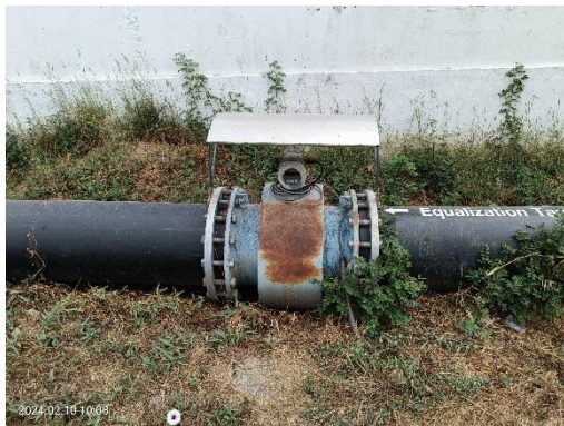
ภาพที่ 2-2 เครื่องวัดอัตราการไหล ของน้ำเสียก่อนเข้าระบบบำบัดน้ำเสีย
