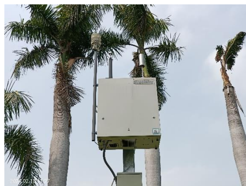
ภาพที่ 2-22 เครื่องตรวจวัดคุณภาพอากาศแบบต่อเนื่อง AQMS
